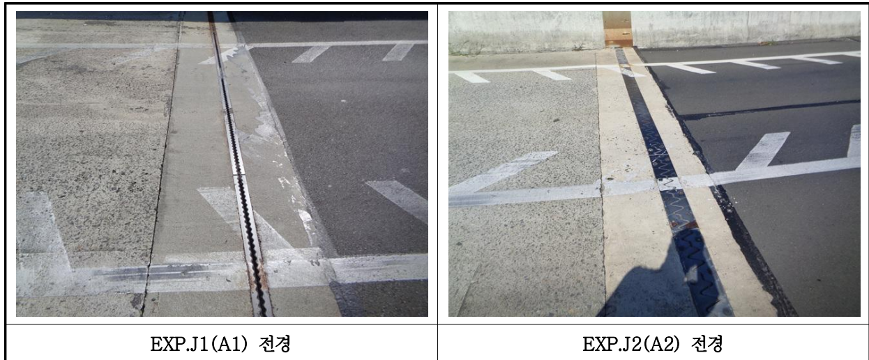
【사진 28.3.14】 신축이음장치 전경
