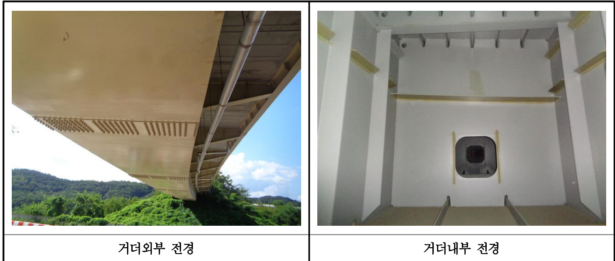
【사진 28.3.4】 거더 전경
