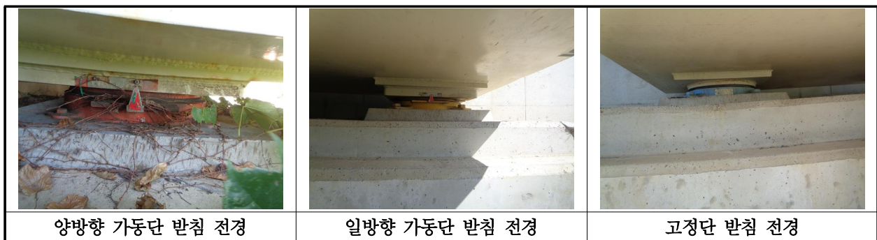
【사진 28.3.10】 교량받침 전경
