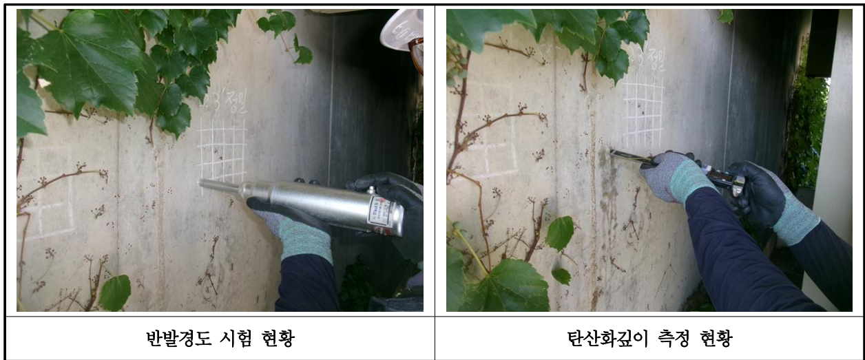
【사진 28.4.1】 콘크리트 내구성조사 현황
