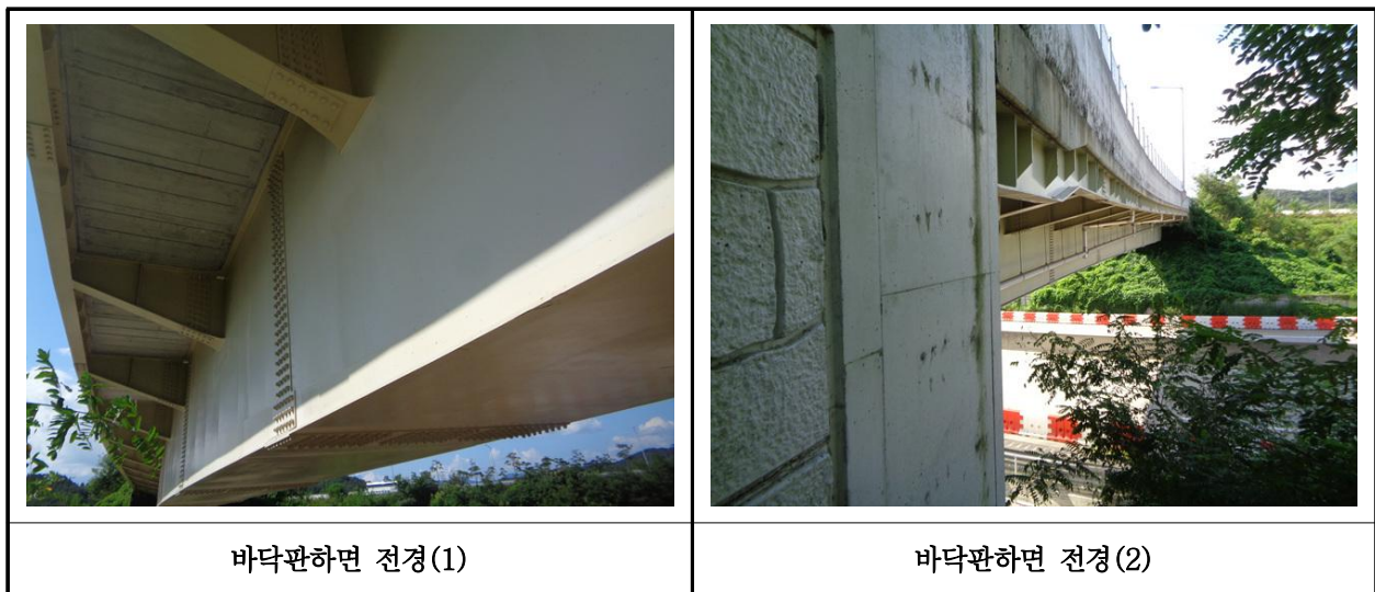
【사진 28.3.2】 바닥판하면 전경
